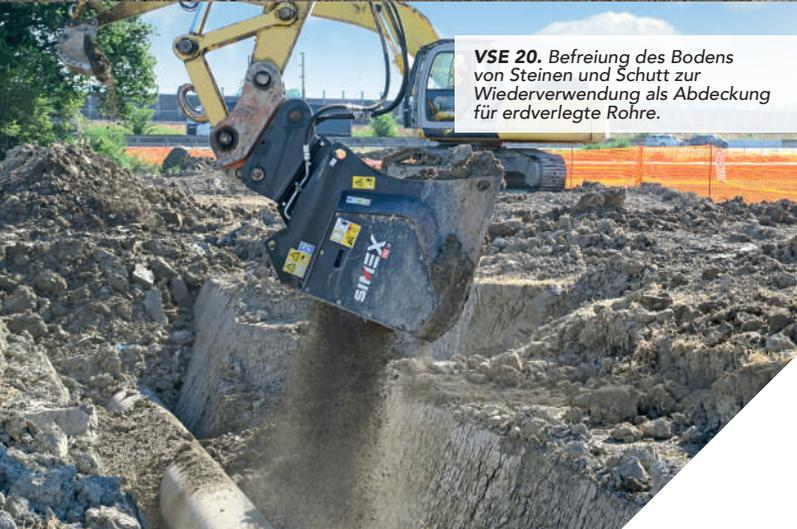
**VSE 20.** Befreiung des Bodens von Steinen und Schutt zur Wiederverwendung als Abdeckung für erdverlegte Rohre.
