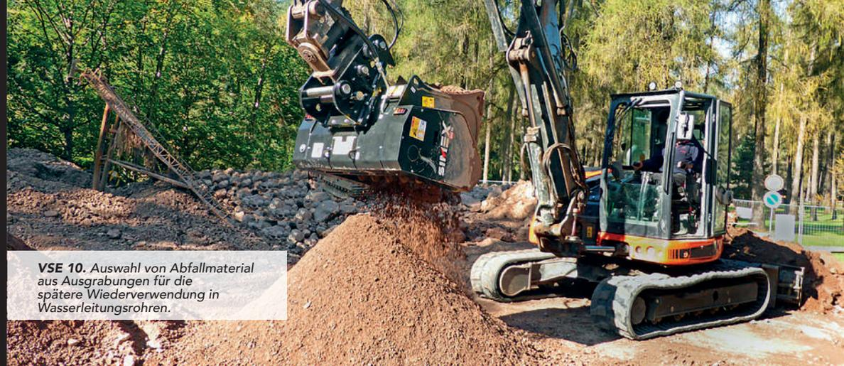
**VSE 10.** Auswahl von Abfallmaterial aus Ausgrabungen für die spätere Wiederverwendung in Wasserleitungsrohren.
